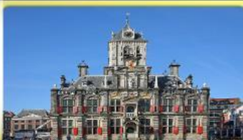
อาคารเมืองเก่าคลองเมืองเคสเฟท์
